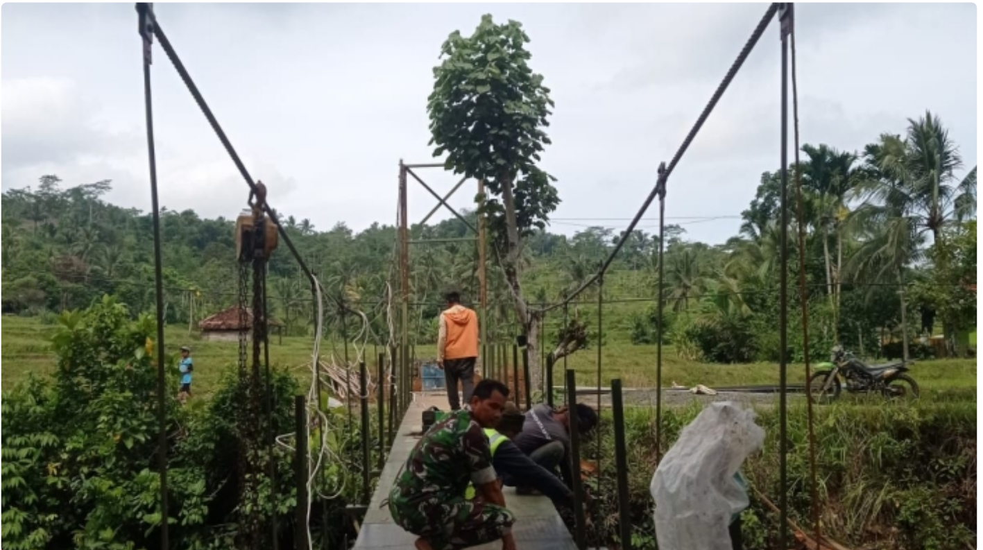
Kpt Arm Witono: Pengerjaan Jembatan Gantung Sudah 80%
